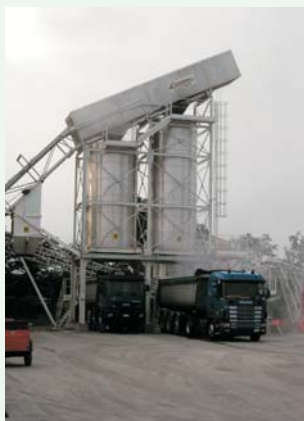
Impianto ETS di Piacenza
